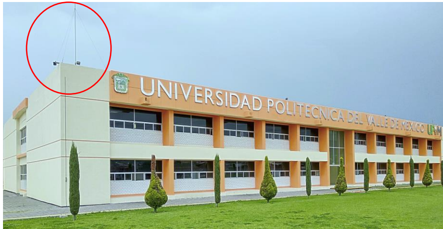
Fotografía del Edificio "C" de la UPVM
