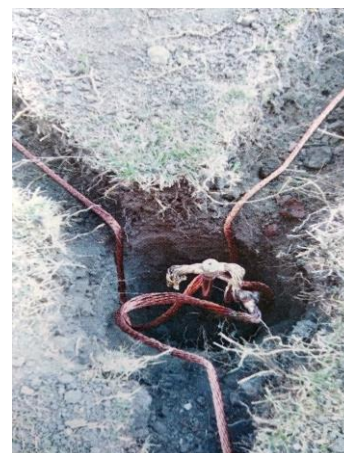
Excavación para delta de edificio "F" de la UPVM
