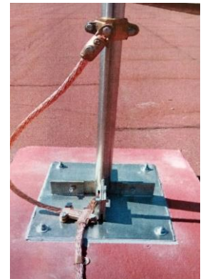
Dado de concreto para base de mástil
